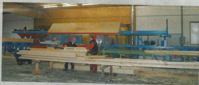
In der zweiten Bauphase wurde nunmehr die computergesteuerte Abbundanlage des Typs K1 durch den neuen Typ K3 CNC ersetzt. Die neue Anlage erlaubt eine weitaus flexiblere, präzisere und wesentlich schnellere Bearbeitung des Rohstoffes Holz.
