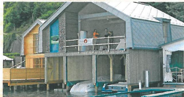
Worthersee: Bootshaus mit Mansardendach, Riegelbauweise, Fassade: Lärchentrapez- und Rhombusleisten, Anlegesteg für Boote.
