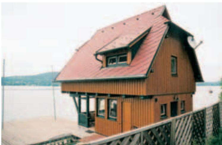
*Bootshaus mit Seepavillon, ausgeführt in Holzriegelbauweise mit Lärchenfassade.*
