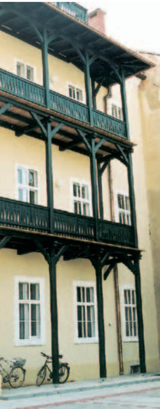
*Mehrgeschossiger Balkonanbau im Innenhof eines Stadthauses, das im Zug der Altbausanierung erneuert wurde. Die Ausführung entspricht im Detail der ursprünglichen Konstruktion.*
