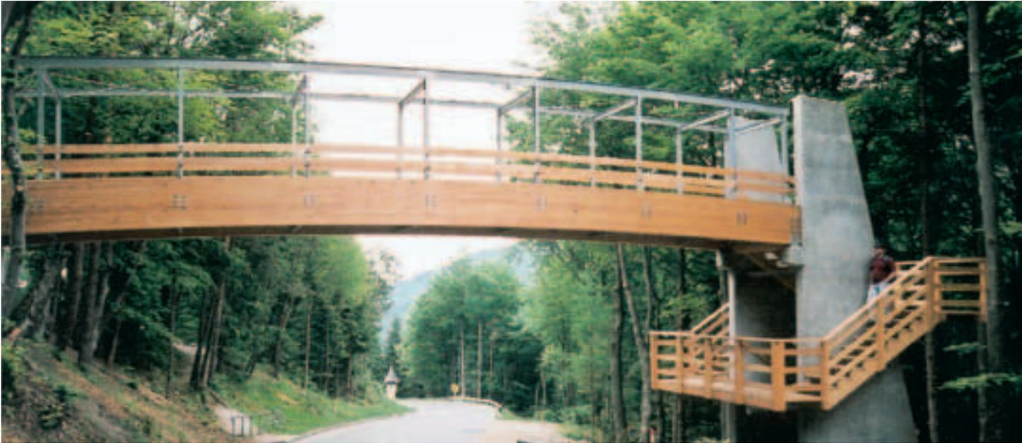
*Brücke über Bundesstraße mit selbsttragender Stiegenkonstruktion in Lärche als Verbindung zwischen Erlebnisschlucht und Parkplatz.*
